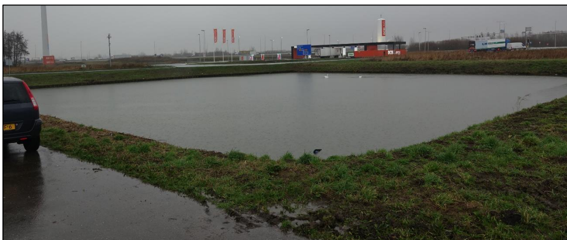
Figuur 4: De waterberging aan de westzijde van het plangebied, gezien vanuit de zuidelijke hoek richting het noorden, wordt in zijn geheel gedempt.
