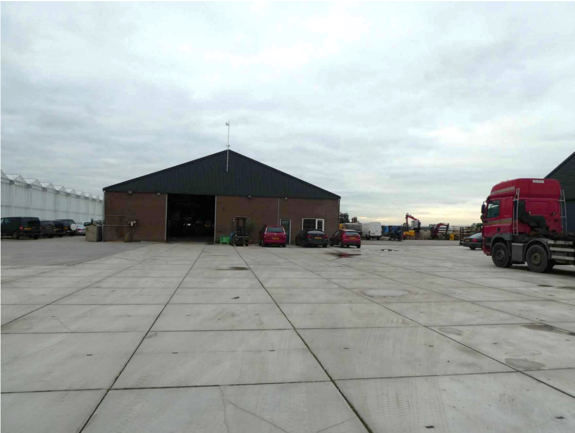
Figuur 3 Plangebied, sterk verhard met zich op te handhaven bedrijfshal
