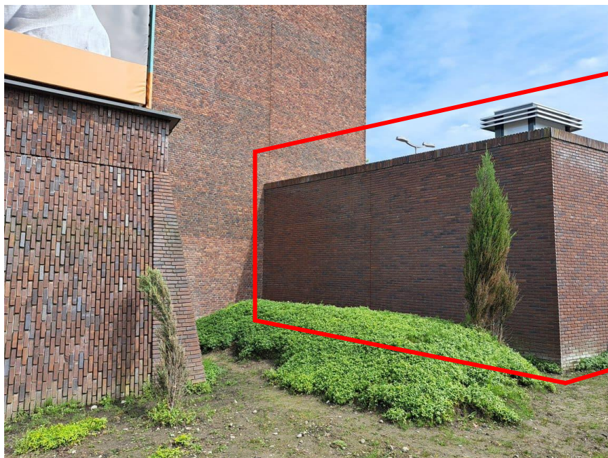
foto 2: Een overzicht van het oosten van het plangebied. Het rood omlijnde bakstenen gebouw vormt het onderzoeksobject
