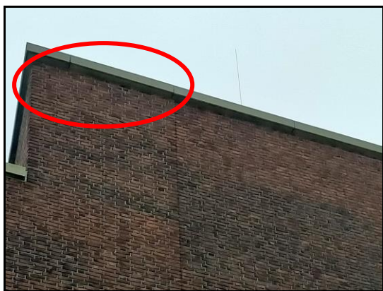
Afbeelding 4: Opening naar spouwmuur (1)
