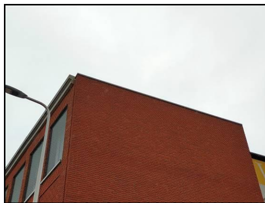
Afbeelding 5: Ruimte onder dakrand (2)
