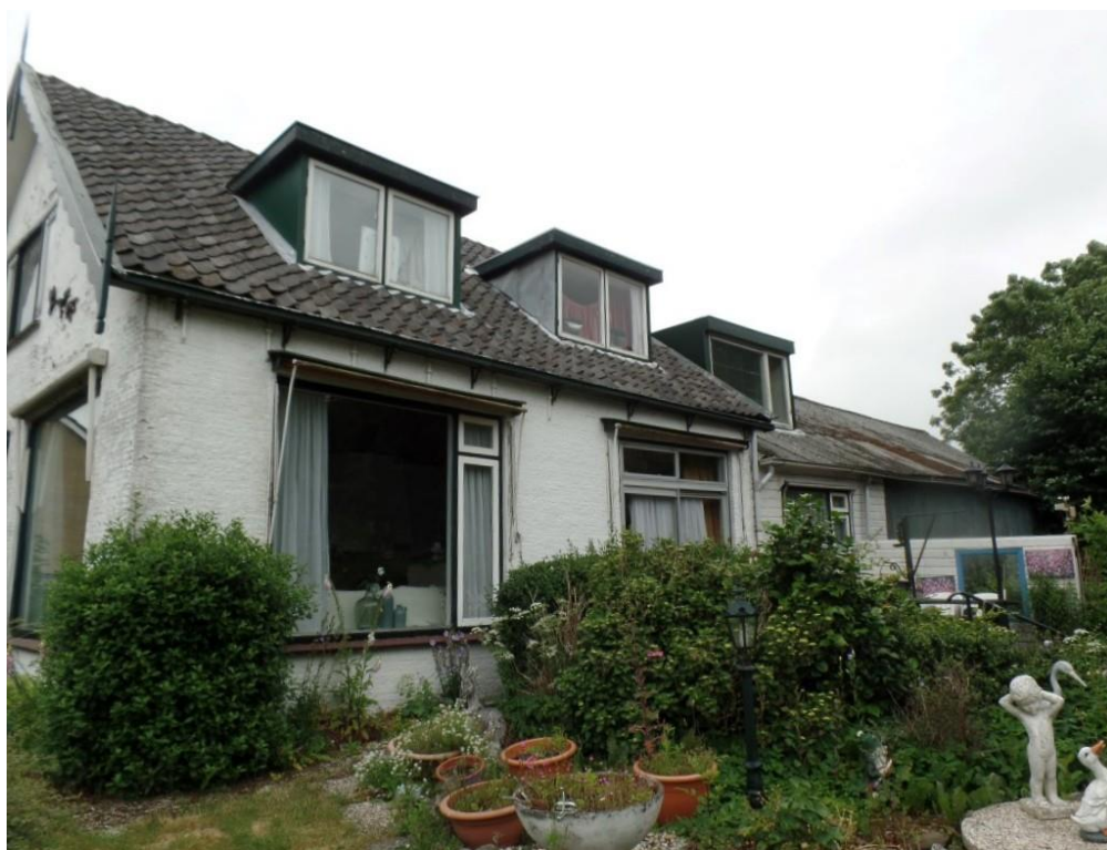
Figuur 10: Dak van het woonhuis en van de loods (zuidzijde).
