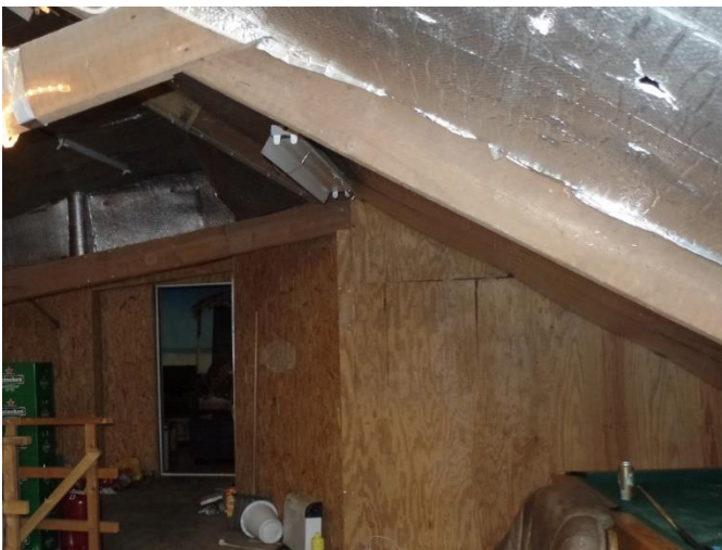
Figuur 14: dakisolatie op de verdieping van de loods.
