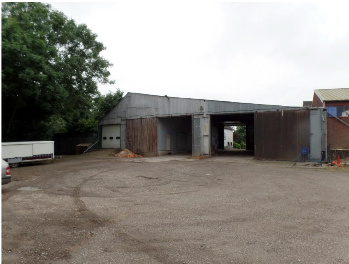
Figuur 8: Gezicht vanaf het parkeerterrein op de loods en (daarachter) het woonhuis.
