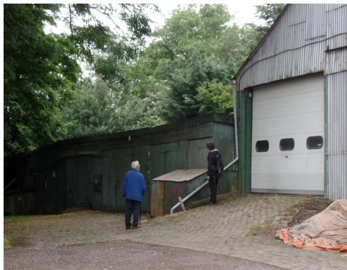
Figuur 12: de schuurtjes aan de zuidoostzijde van het terrein.
