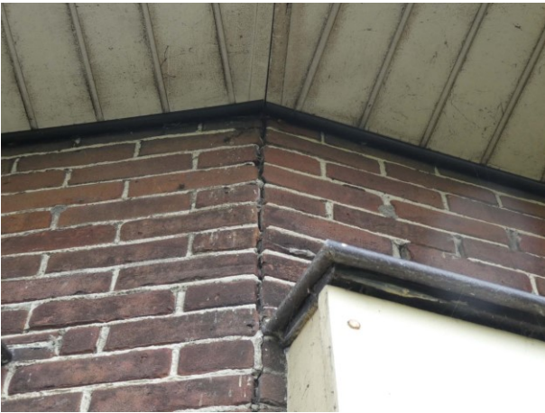
Figuur 30 Aansluiting boeiboord op de muur
