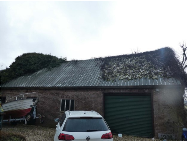
Figuur 25 Overzicht noordzijde van de schuur
