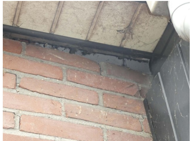
Figuur 33 Detailfoto ruimte achter het boeiboord waar endoscopisch onderzoek is uitgevoerd
