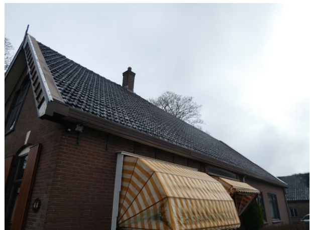
Figuur 3 Overzicht dak van het woonhuis
