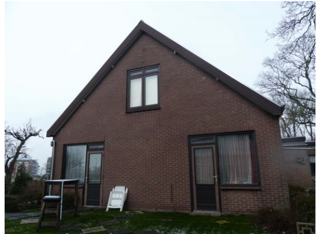
Figuur 5 Zuidelijke kopgevel woonhuis
