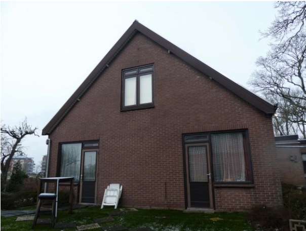
Figuur 28 Overzicht zuidelijke kopgevel
