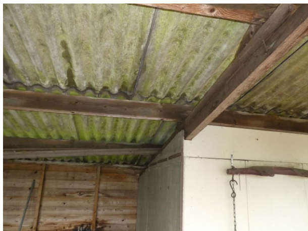
Figuur 21 Onderzijde dak van de overkapping
