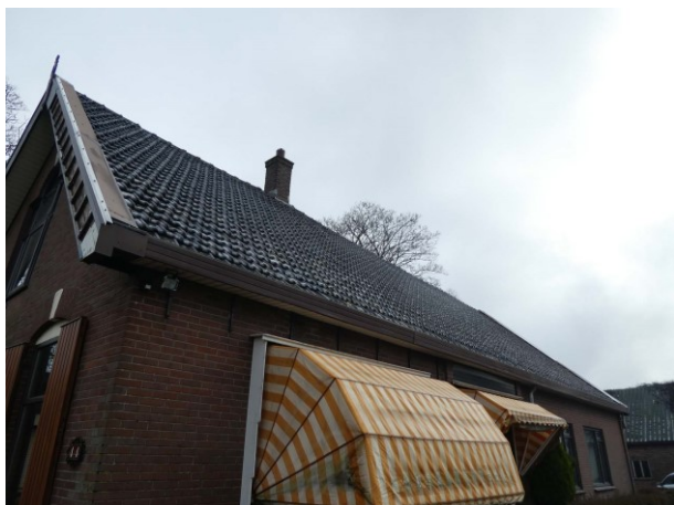
Figuur 22 Overzicht dak van de woning
