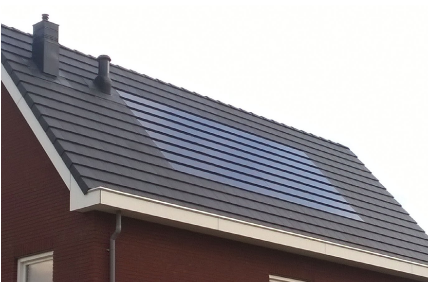
zonnepanelen aan de voorzijde geïntegreerd in het dakvlak en afgestemd qua kleur
