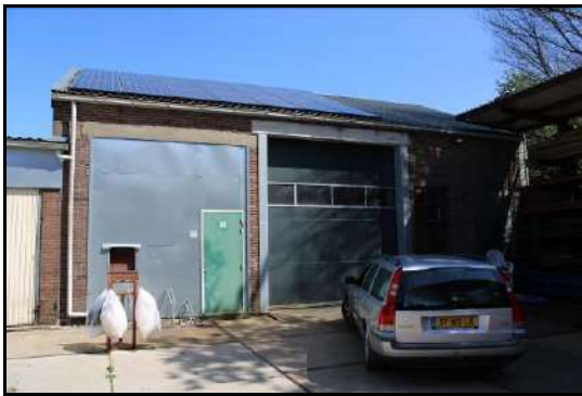
Afbeelding 8: Mogelijkheden onder zonnepanelen en dakgoot in projectgebied
