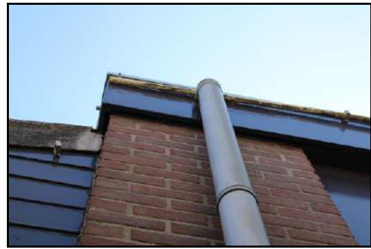
Afbeelding 8: Openingen onder dakrand
