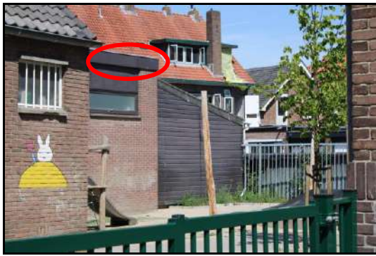
Afbeelding 7: Openingen onder dakrand
