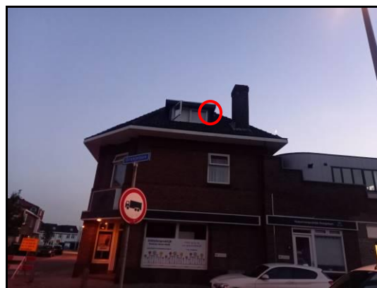
Afbeelding 2: Bezet nest gierzwaluw Oranjelaan 7D hoek noordzijde dakkapel grenzend aan dakpannen
