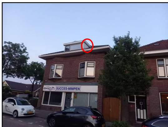
Afbeelding 1: Bezet nest gierzwaluw Oranjelaan 2 hoek westzijde dakkapel grenzend aan dakpannen
