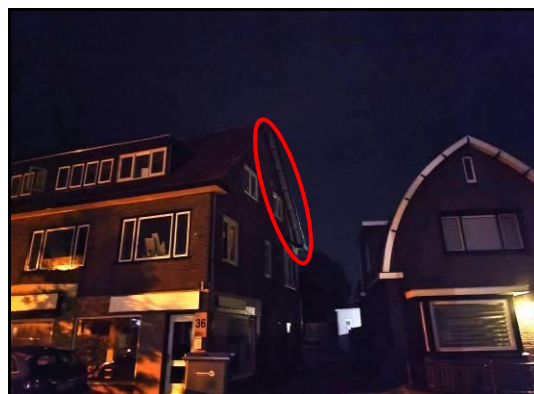
Afbeelding 4: Zomerverblijfplaats laatvlieger zuidzijde Oranjelaan 36A onder dakoverstek
