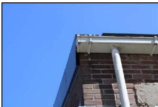
Afbeelding 3: Openingen achter platen
