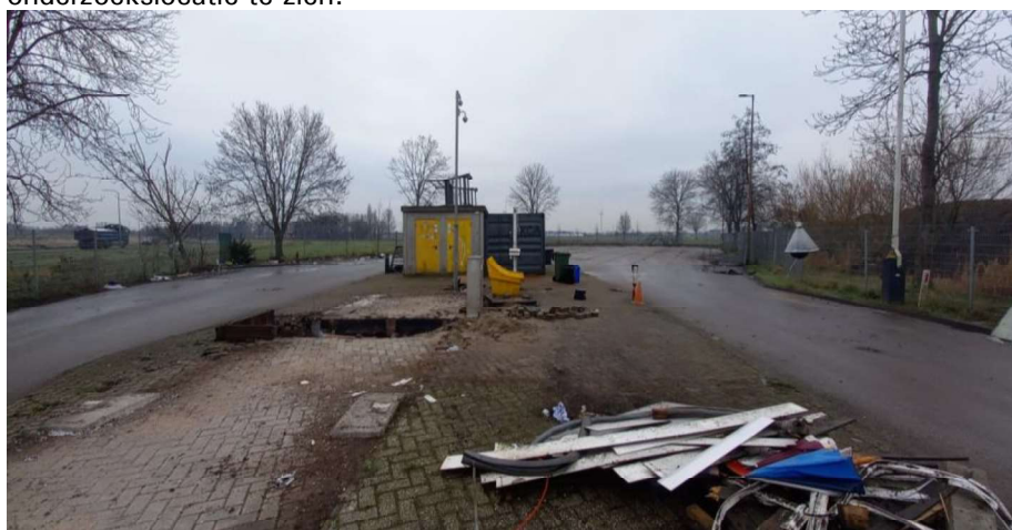
Afbeelding 2.3: Entree van de onderzoekslocatie (bron 7)
