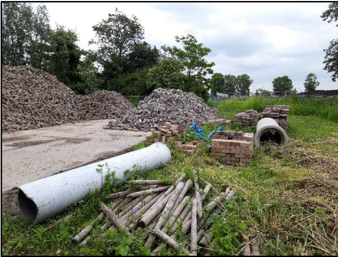
Foto 7: Werkterrein met opslag materialen noordelijk van de locatie (2)
