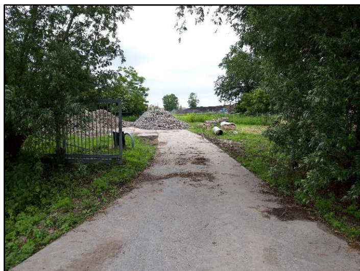
Foto 6: Werkterrein met opslag materialen noordelijk van de locatie (1)
