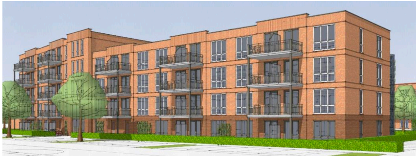
Parkrijk, Stol architecten.
