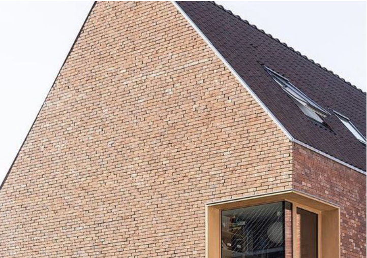
Keramische donkere dakpannen met strakke detaillering.
