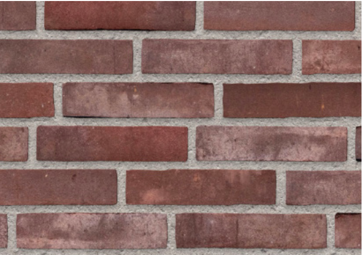
Metselwerk in een rode tint.
