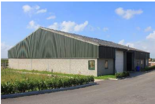
De bestaande (uit te breiden) stal.
