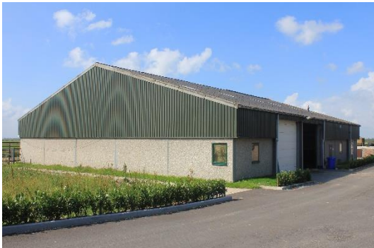
De bestaande (uit te breiden) stal.
