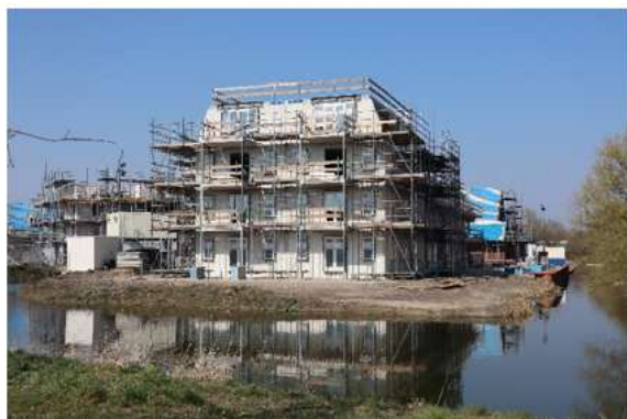
Woningbouw in Triangel Noordpunt.
