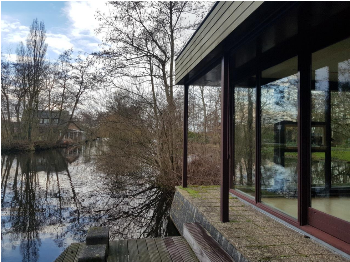
Afbeelding 5: Achterzijde bestaande toestand gebouw
