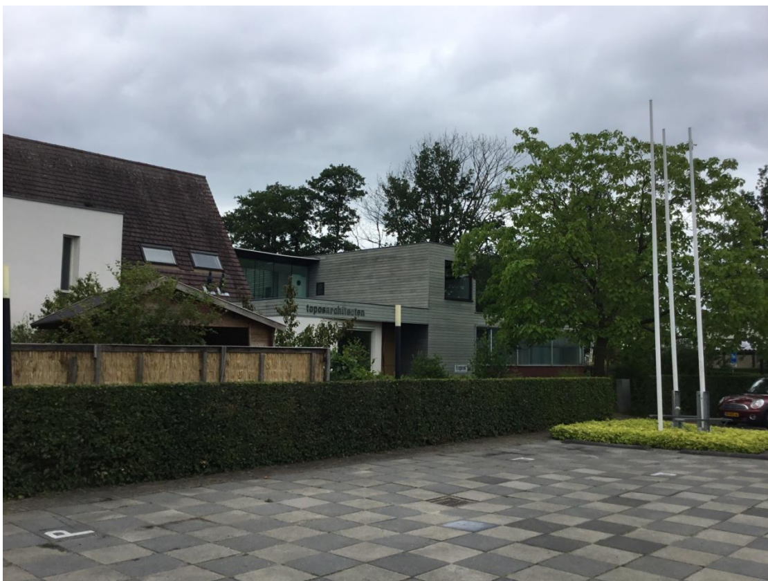
Afbeelding 4: Voorzijde bestaande toestand gebouw
