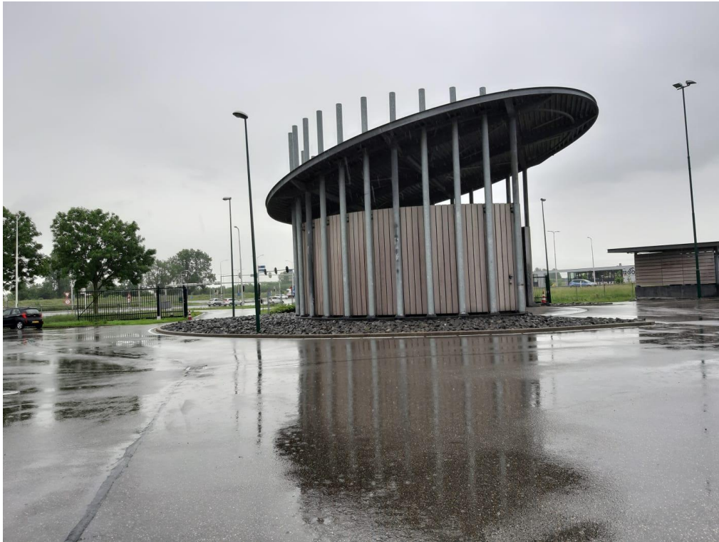
Figuur 5 Gebouw 2, zie ook Figuur 3.
