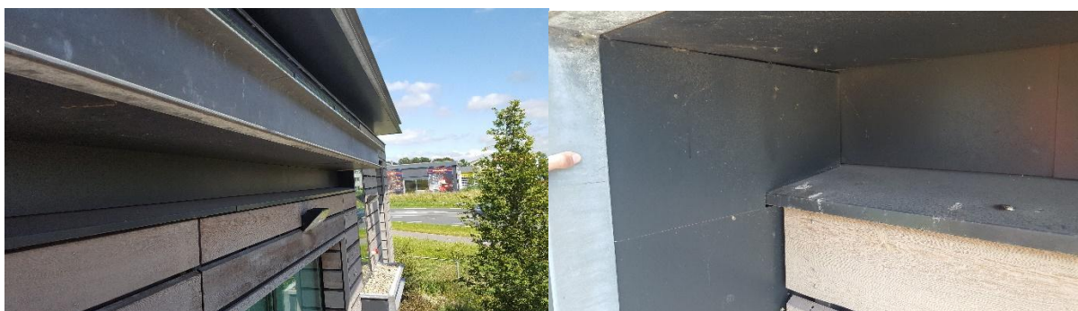
Figuur 10 Foto links: Metalen constructie dak. Foto rechts: Trespapier ter hoogte van de dakrand.
