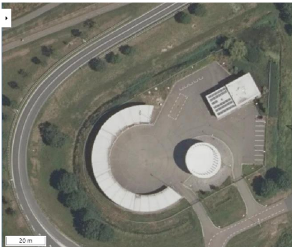
Figuur 2 Huidige situatie wegesteunpunt Coenecoop
