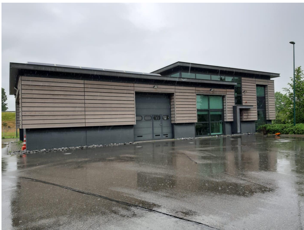
Figuur 7 Gebouw 3, zie ook Figuur 3.
