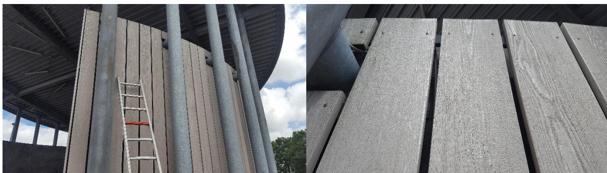
Figuur 6 Foto links: Metalen constructie dak en houten bekleding van de zijkant. Foto rechts: Houten bekleding zijkant met open constructie aan de bovenkant.
