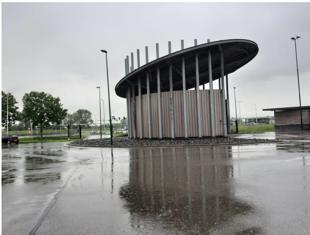
Figuur 5 Gebouw 2, zie ook Figuur 3.
