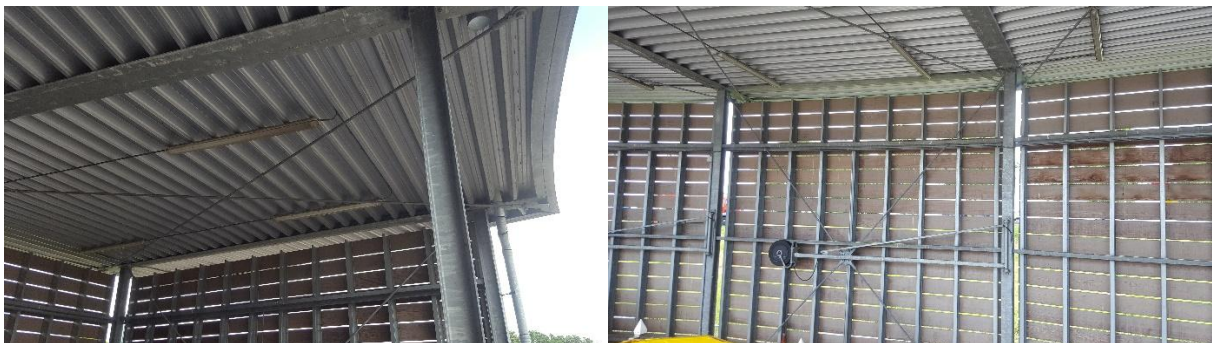
Figuur 4 Foto links: metalen constructie dak. Foto rechts: metalen constructie bekleed met houten planken.
