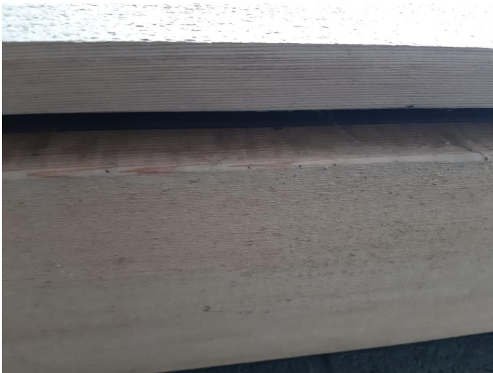
Figuur 9 Open ruimte tussen houten beplating kantoorgebouw.
