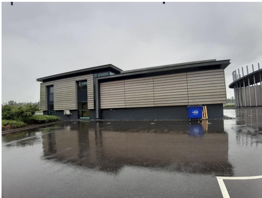
Figuur 5 Kantoorgebouw - achterzijde.
