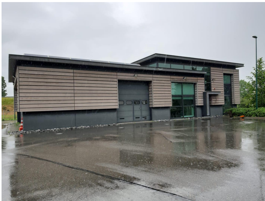
Figuur 4 Kantoorgebouw - voorzijde.
