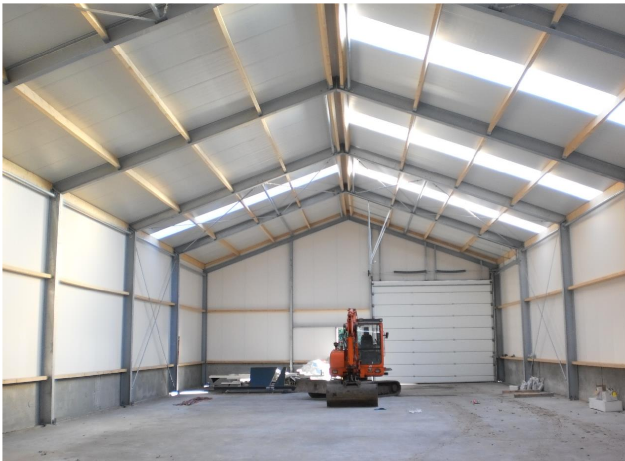
De bestaande loods
