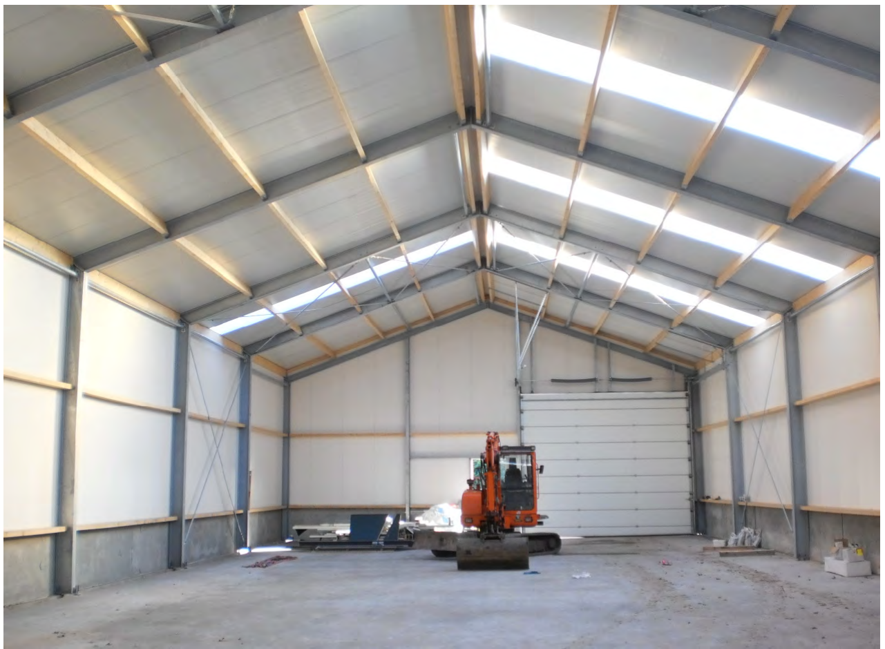
De bestaande loods
