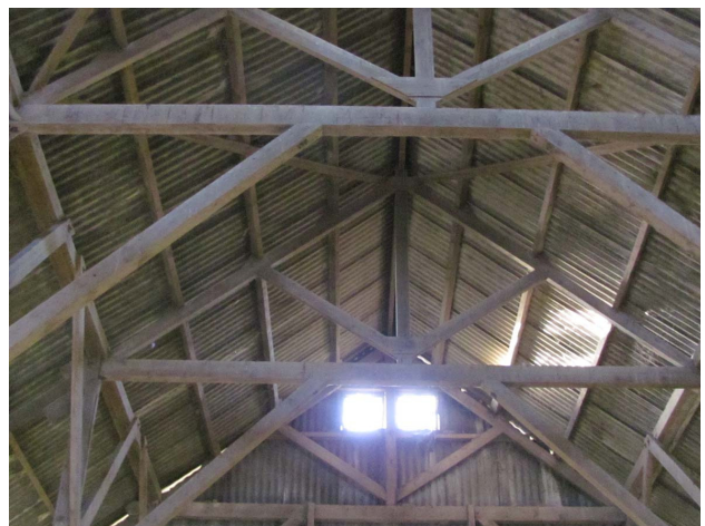
Figuur 6: Balken en dak van de te slopen stal
