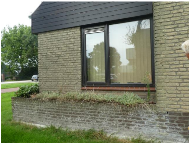
Figuur 15 Zijgevel woning, lage open stootvoegen
