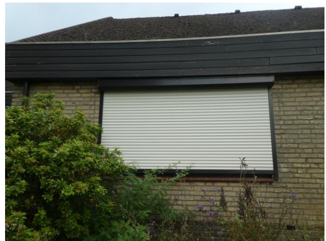
Figuur 16 Voorgevel woning
