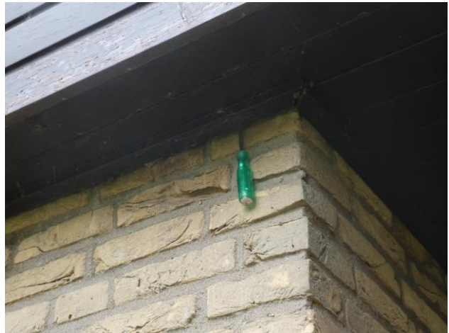
Figuur 14 Inspectie invliegopeningen dakoverstek, geen aanwezig
