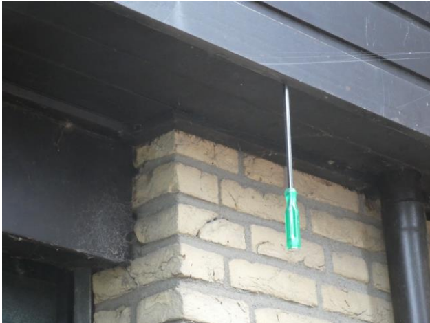
Figuur 13 Inspectie invliegopeningen dakoverstek, geen aanwezig
