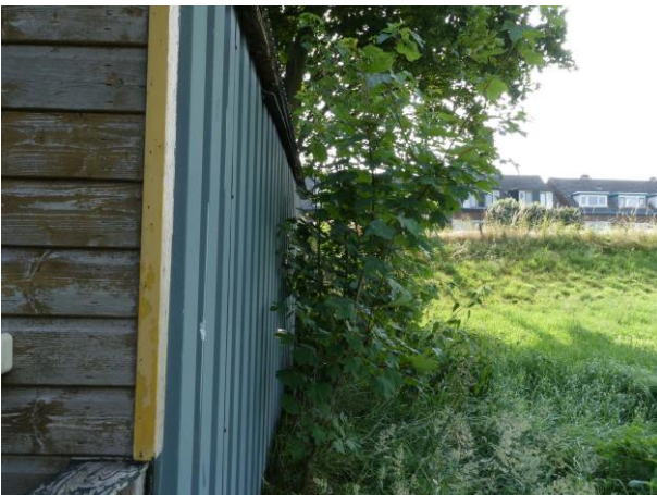
Figuur 19 Damwandmuur zuidelijke schuur voortuin
