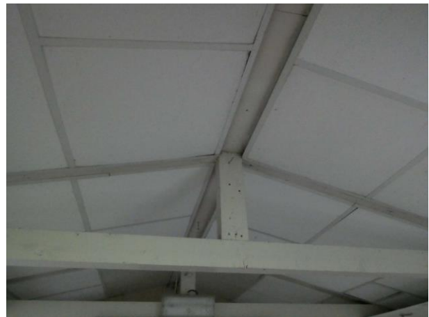
Figuur 20 Binnenzijde schuur met systeemplafond
