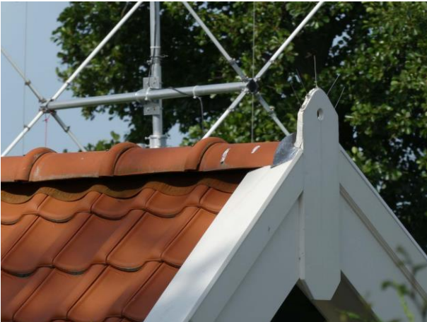
Figuur 31 Overzicht rode dak met vogelwering
