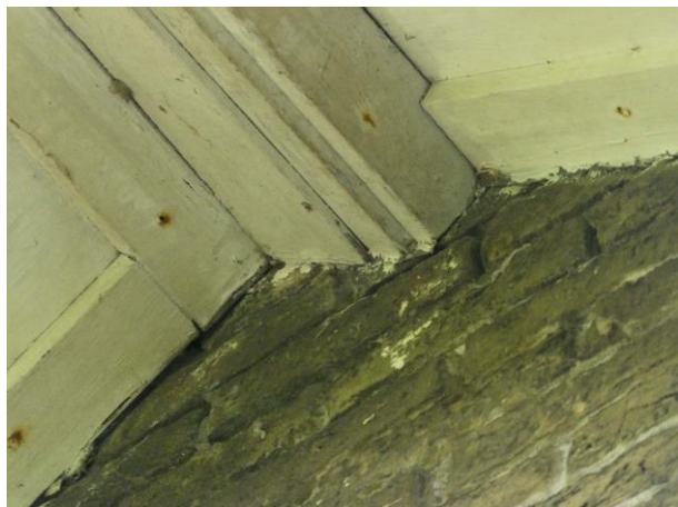
Figuur 22 Detailfoto aansluiting boeiboord
