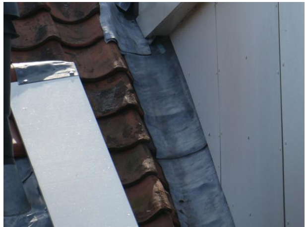
Figuur 28 detailfoto aansluiting dakkapel
