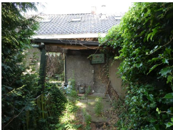
Figuur 25 Overzicht zuidoostelijk dak
