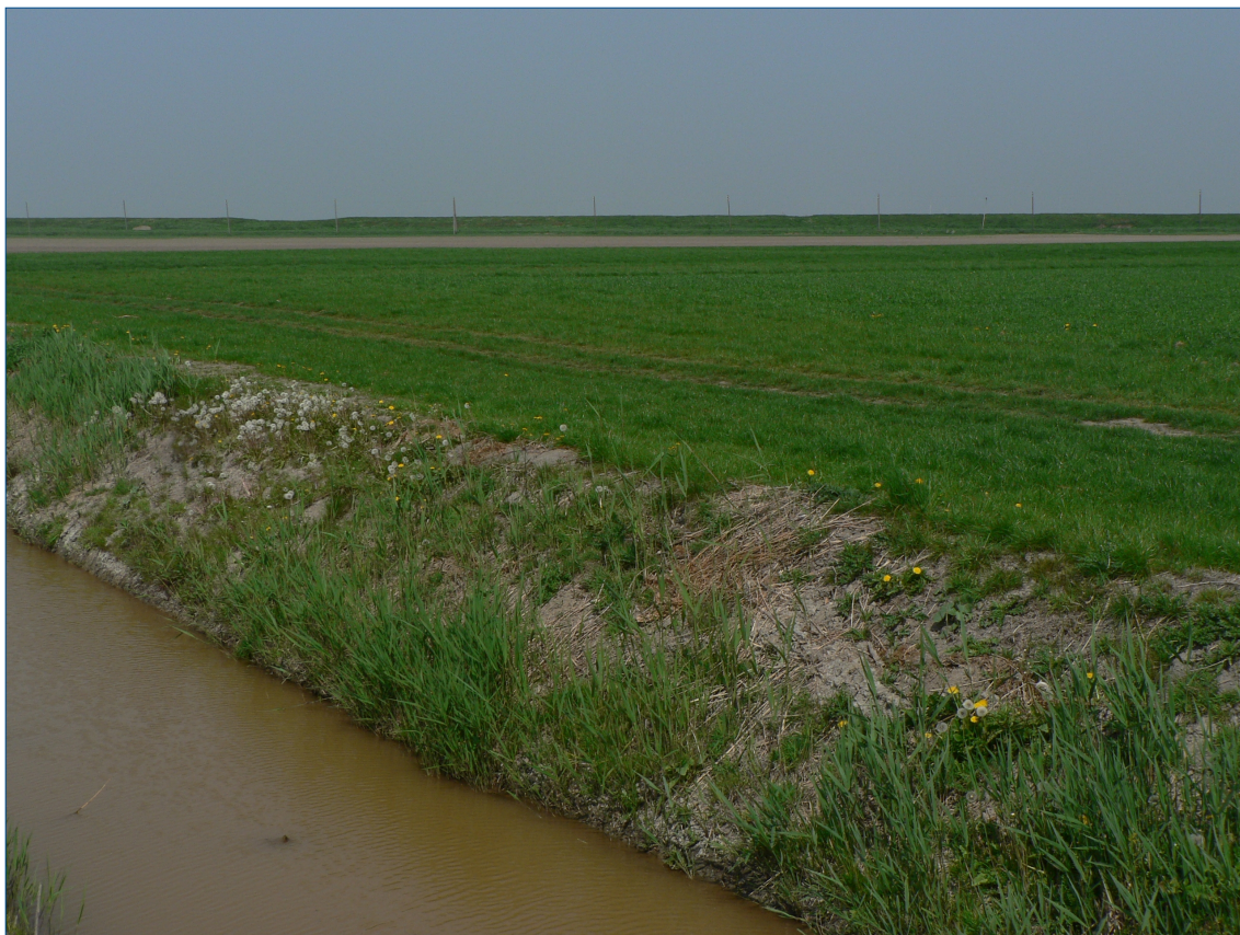
Figuur 11. De Kleikade gezien vanaf de Toernooiweg kijkend naar het noorden, in de kruin zijn duidelijk twee vergravingen zichtbaar op de plaats waar verdedigingswerken de kade kruisten.
