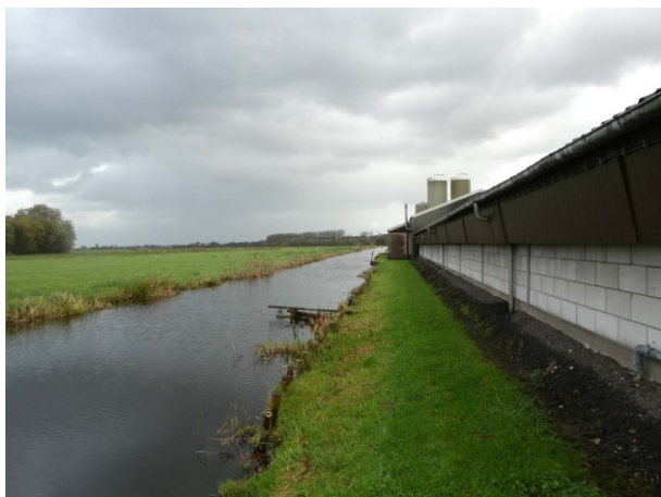
Figuur 4 Noordelijk aanzicht te slopen stallen
