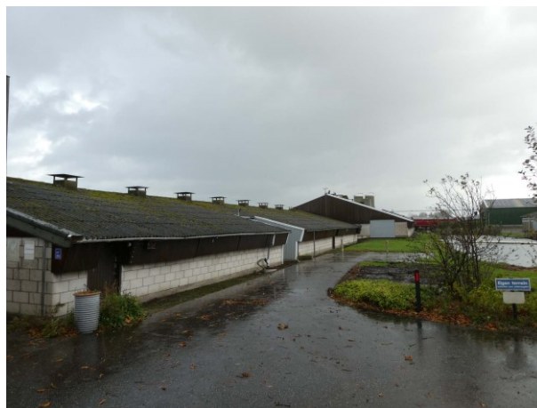
Figuur 3 Overzicht te slopen stallen
