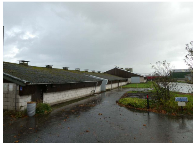
Figuur 3 Overzicht te slopen stallen
