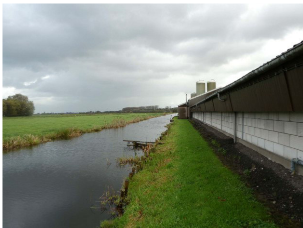
Figuur 4 Noordelijk aanzicht te slopen stallen
