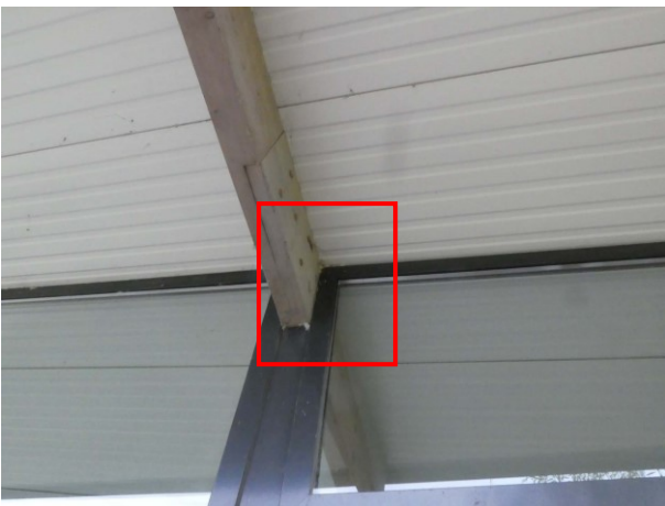
Figuur 23 Overgang glazen pui naar dakoversteek. Rode contour: Figuur 24
