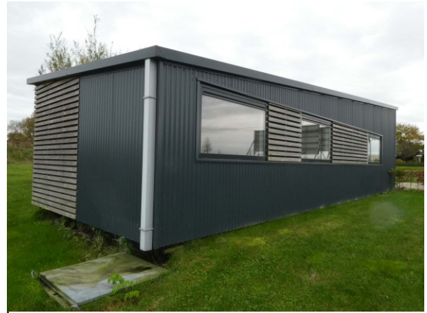
Figuur 16 Achter- en zijgevel van het tijdelijke verkoopgebouw
