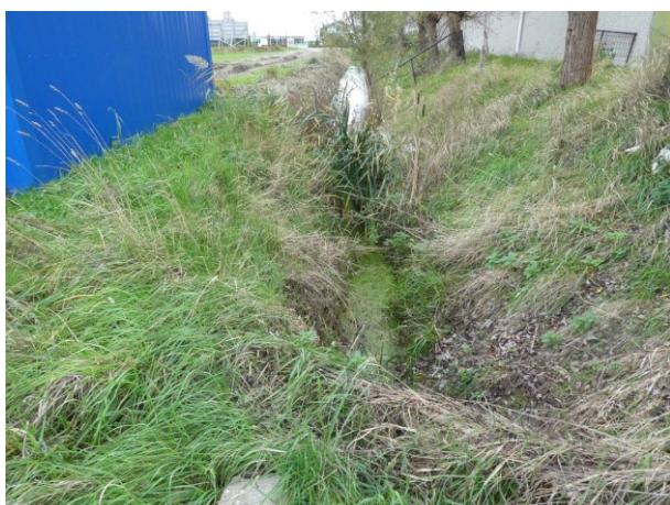
Figuur 13 Sloop aan noordwestelijke grens
