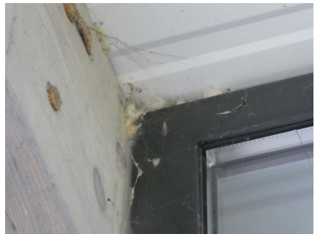
Figuur 24 Spinnennesten op overgang kozijn-dakoversteek aan zuidoostzijde van het gebouw
