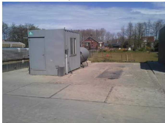
foto 6: wasplaats met bovengrondse tank
