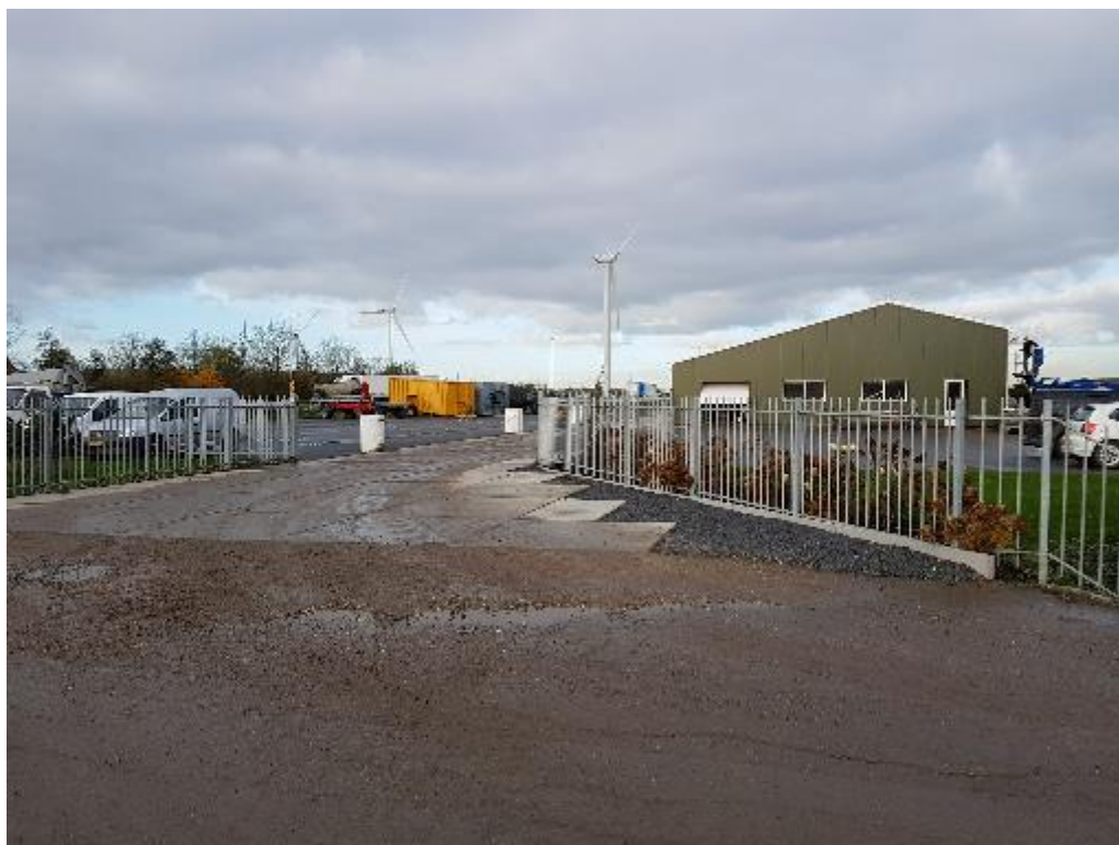
Figuur 1 de westzijde van het poerceil is gebruik voor bedrijfsactiviteiten. Het terrein is omrand door een kavelsloot en grotendeels verhard. Tevens is een grote loods aanwezig.
