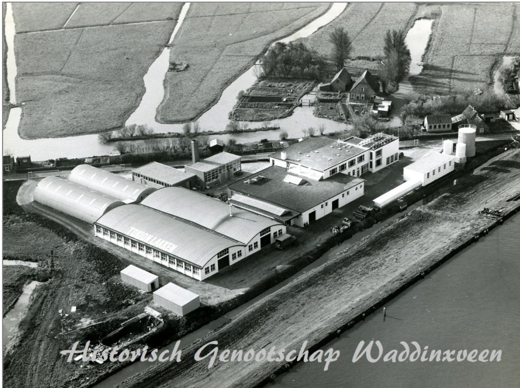
Afb. 12 Luchtfoto van het plangebied, genomen omstreeks 1970, met daarop de Lak- en Vernisfabriek van Wed. Boonstoppel en Zn. 47
