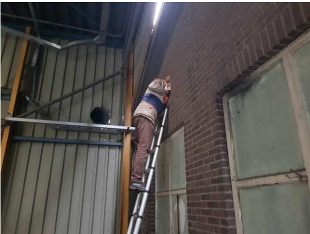
Figuur 11: Onderzoek van de spouw met zaklamp
