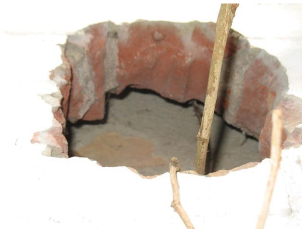
Figuur 17: Kier onder boeiboord (l) en toegang naar spouw ( r)
