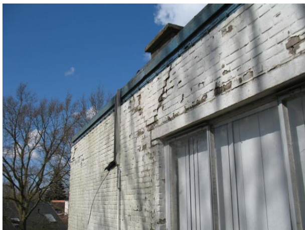
Figuur 16: Scheuren en kieren in de gevel (l) en (r)
