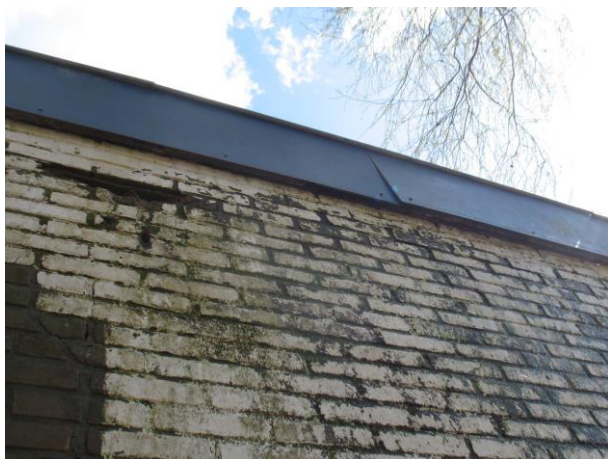
Figuur 17: Kier onder boeiboord (l) en toegang naar spouw ( r)
