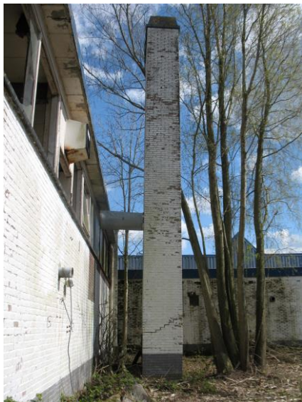
Figuur 6: Schoorsteenpijp aan de westzijde
