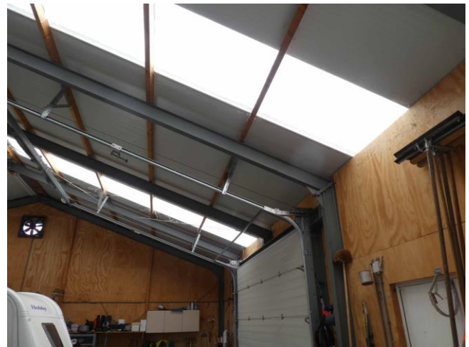
Figuur 8: Binnenzijde schuur nr. 16
