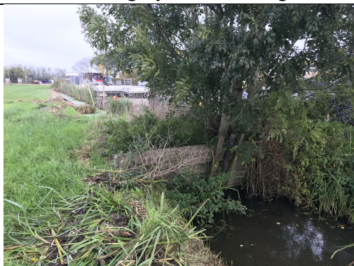
08 Aarde dam zijkanten van betonnen balken
