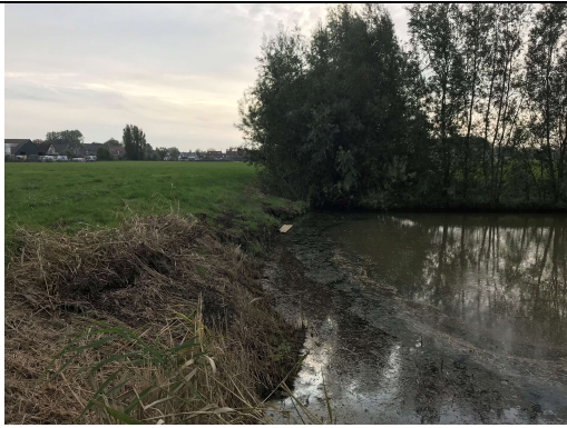
17 Kant sloot geen beschoeiing
