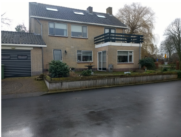
Foto 1: Woonhuis, gezien in zuidoostelijke richting
