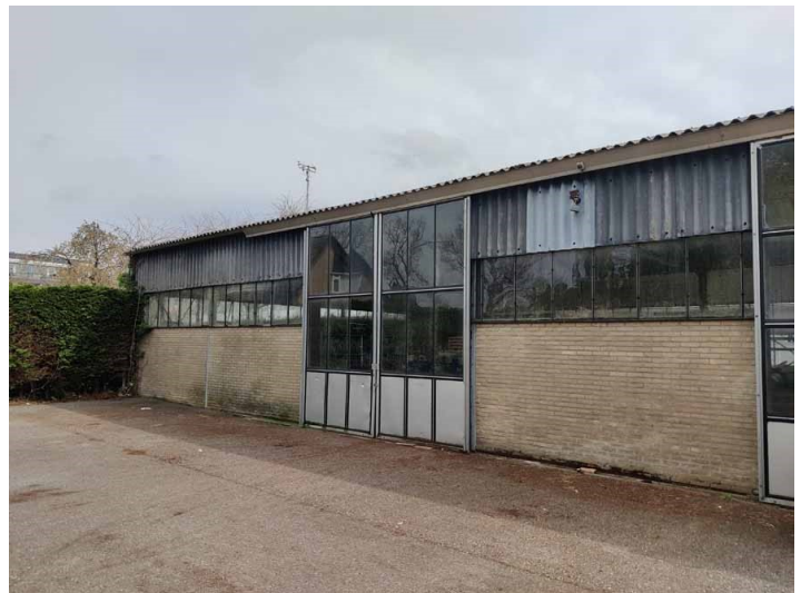
Figuur 15 Voorkant van de bedrijfsloods aan de noordwestzijde met veel glas en zwarte golfplaten als dak
