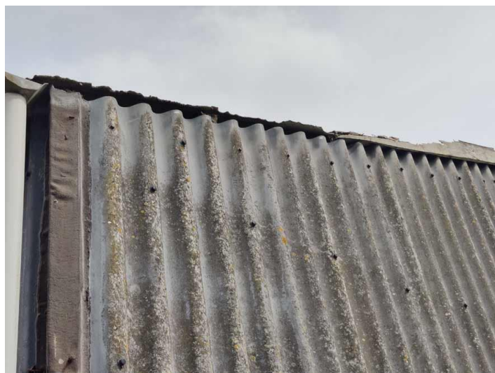
Figuur 13 Zwarte golfplaten aan de zuidzijde van de bedrijfsloods
