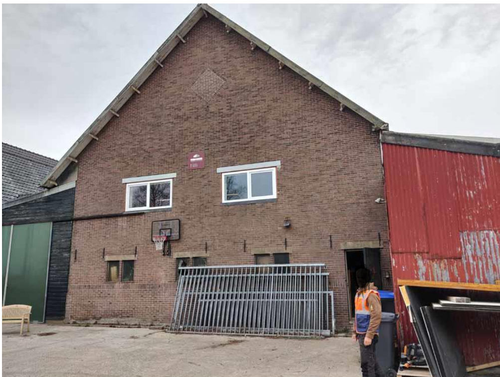
Figuur 4 Zuidoost aanzicht van de loods
