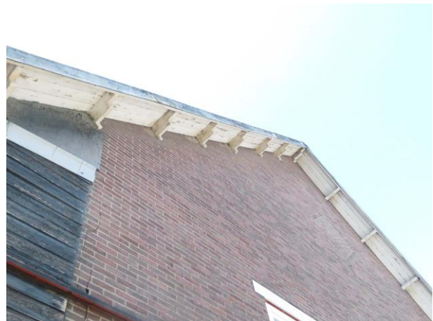
Figuur 17 Overzicht boeiboorden van de schuur
