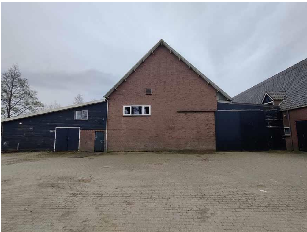
Figuur 2 Noordwestaanzicht van de loods
