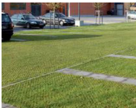
Waterdoorlatende verharding met groene uitstraling op de koppen van de parkeerstroken
