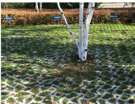
Waterdoorlatende verharding met groene uitstraling op de koppen van de parkeerstroken
