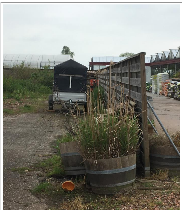
Figuur 10 – Foto huidige schutting op het perceel van TAS Boomkwekerij, met rechts het perceel van TAS Boomkwekerij en links het perceel van initiatiefnemer (met aanhanger). Het geluidsscherm wordt in de perceelsgrens geplaatst, net achter de bestaande schutting, waarbij het geluidsscherm doorloopt tot voorbij de voorgevel van de bestaande woning Otweg 3.
