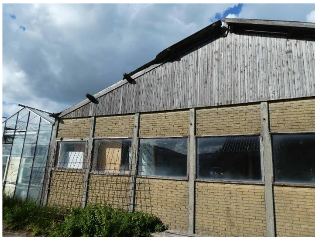
Figuur 10 Kas en schuur op terrein Noordeinde 46
