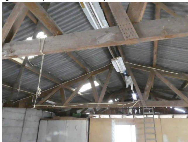
Figuur 14: Binnenzijde loods Noordeinde 46
