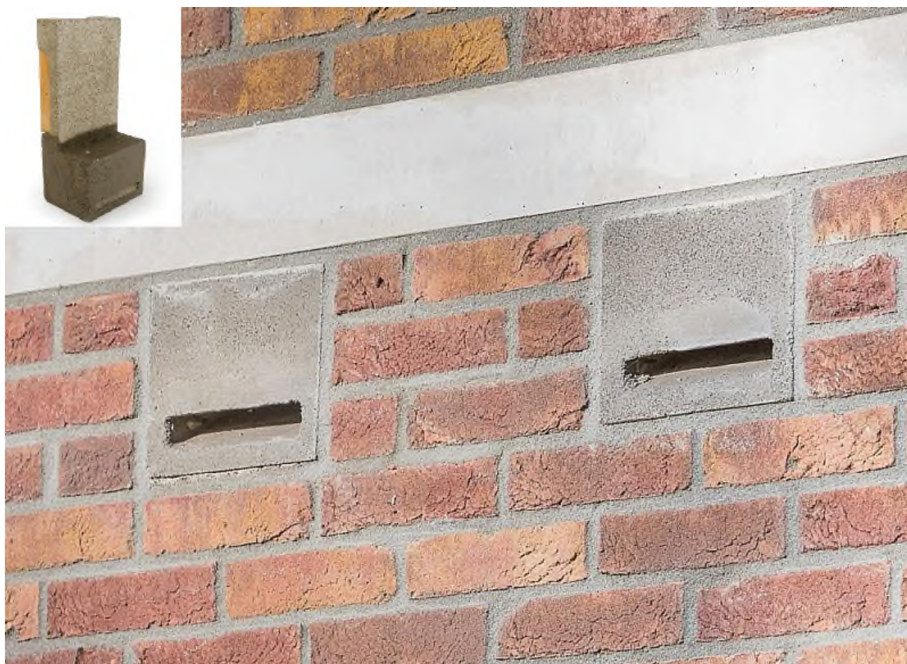
Figuur 5.5 Voorbeeld van inbouwsteen gewone dwergvleermuis
