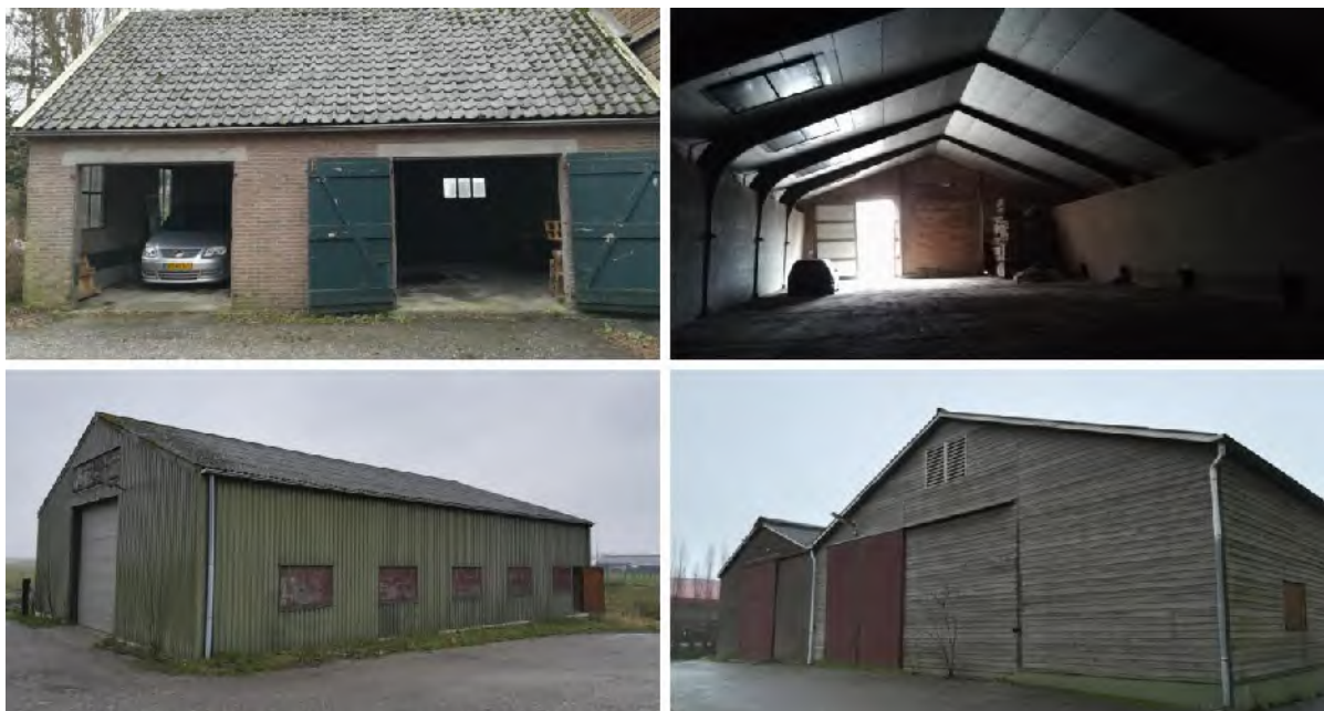
Figuur 3.3. Impressie van het plangebied. Linksboven de garages, rechtsboven de binnenkant van de aardappelschuur, linksonder de losstaande aardappelschuur en rechtsonder de andere aardappelschuur aan werkschuur.
