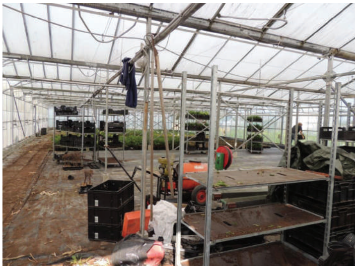
Oude situatie, deze kassen zijn verwijderd
