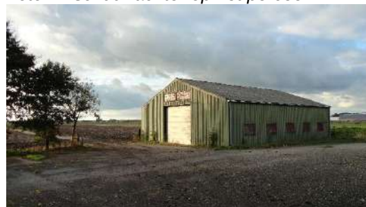
Foto 22 schuur achter op het perceel
