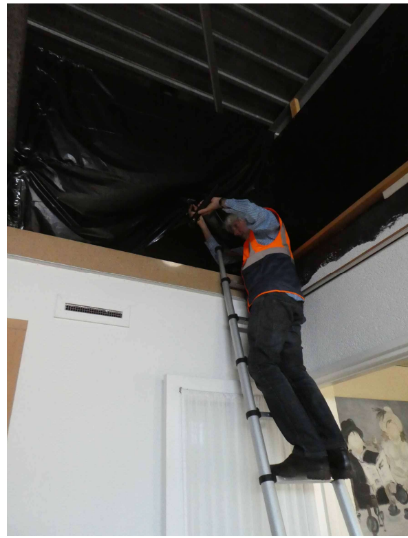
Figuur 20 Inspectie binnenzijde winkelpand
