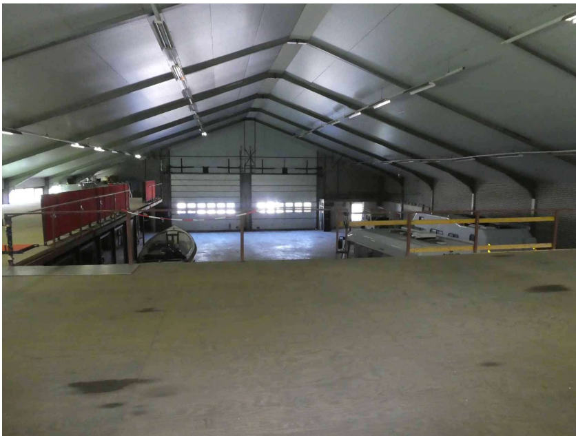
Figuur 4 Binnenzijde bedrijfshal
