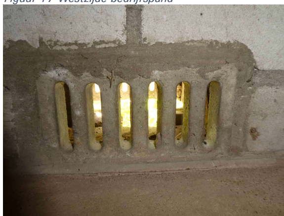
Figuur 15 Ventilatioerooster laag bij de grond
