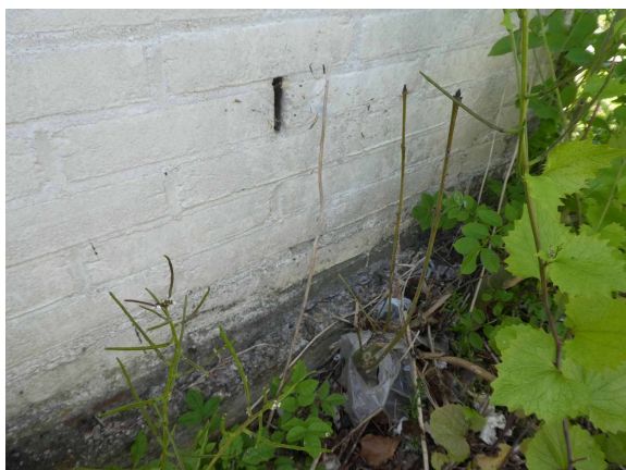
Figuur 14 Stootvoegen laag bij de grond
