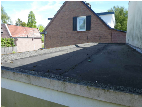
Figuur 21 Bitumen dak
