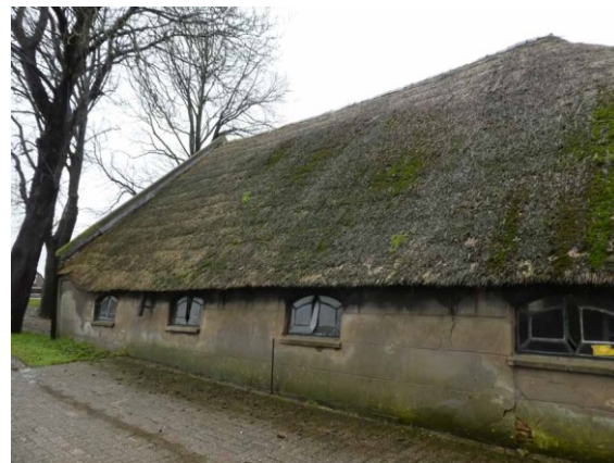
Figuur 18 Zijgevel voormalige stal
