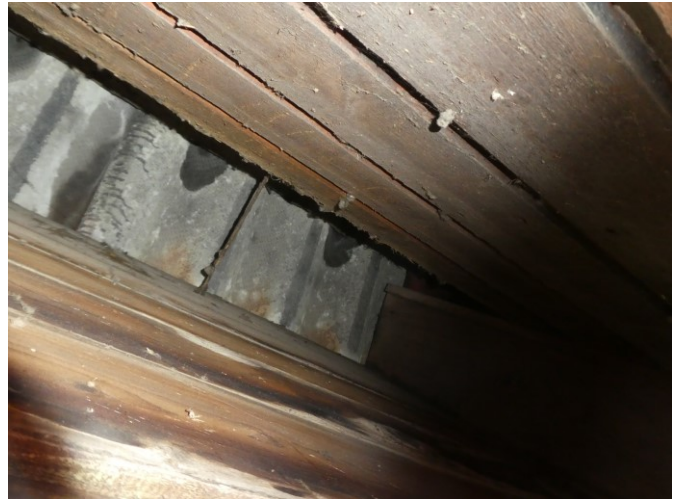
Figuur 26 Binnenzijde overstek
