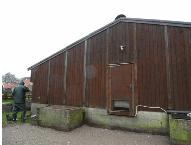
Figuur 23 Achtergevel bedrijfsloods
