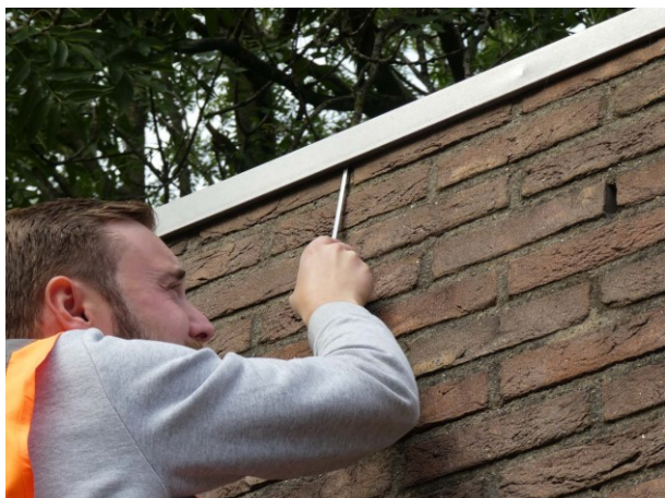
Figuur 11: Schroevendraaier onder gebogen stuk daktrim.
