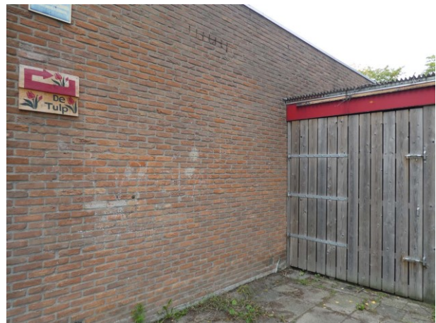
Figuur 27: Deur met openingen aan de oostkant.
