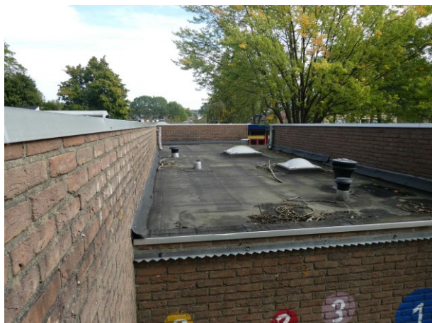
Figuur 10: Hoogteverschil van het dak.
