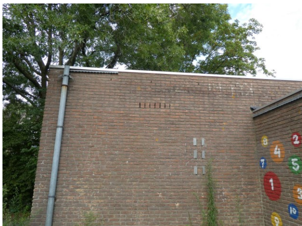
Figuur 17: Buitenmuur met stootvoegen.
