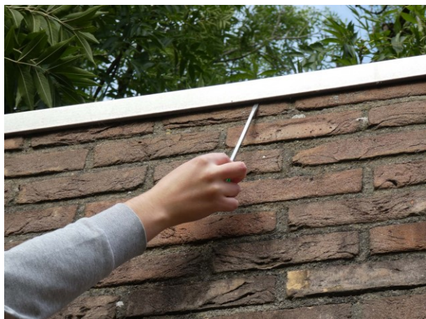
Figuur 12: Schroevendraaier onder daktrim.
