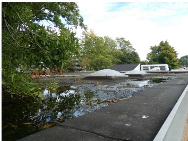
Figuur 9: Platte dak van het schoolgebouw.
