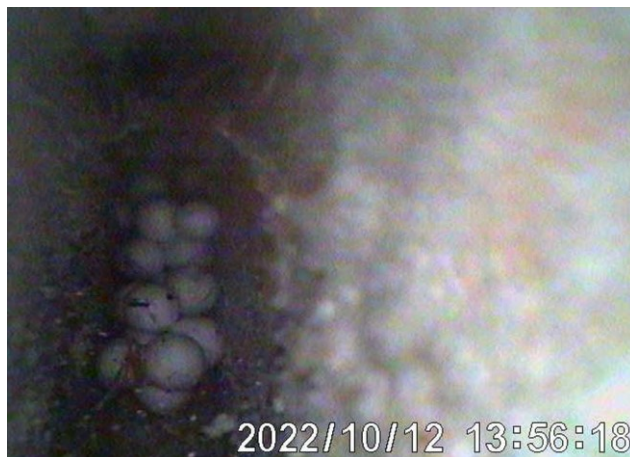
Figuur 18: Gesloten stootvoeg met tempex.
