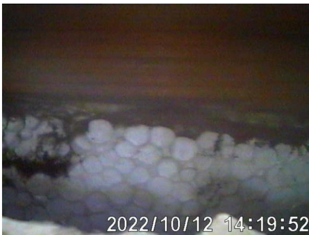
Figuur 22: Tempex isolatie tussen kunststofplaten.
