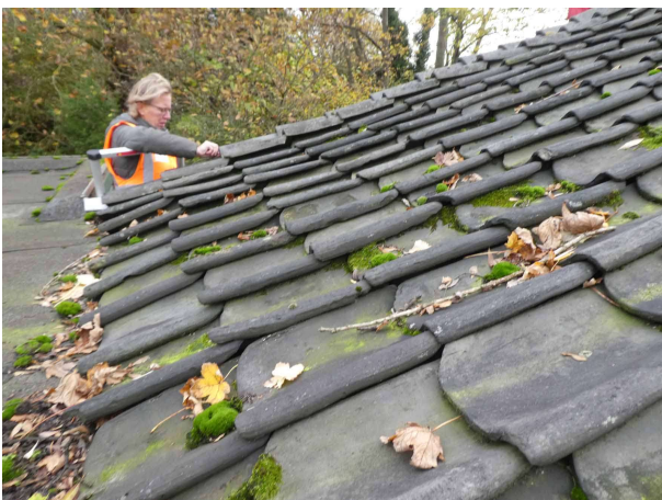
Figuur 8 Inspectie met USB camera onder dakpannen, het rommelige pannendak en de rand bitumen onder de pannen (foto rechts)
