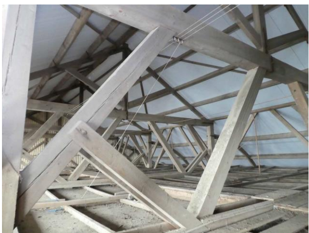
Figuur 22 Binnenzijde dakconstructie schuur 4
