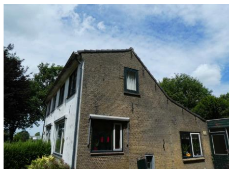
Figuur 27 Zijmuur woning
