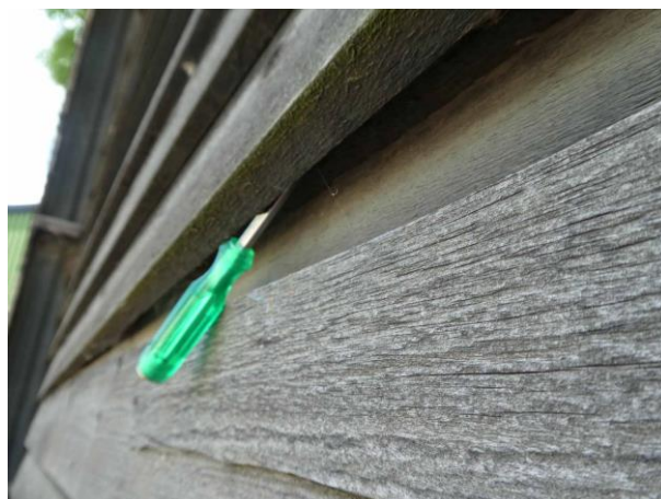
Figuur 17 Wel ruimte, direct naar binnenruimte schuur, dus geen eigen, stabiel microklimaat
