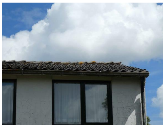
Figuur 26 Dak arbeiderswoning 7-8
