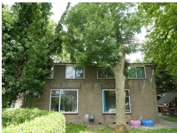
Figuur 29 Voorzijde arbeiderswoningen
