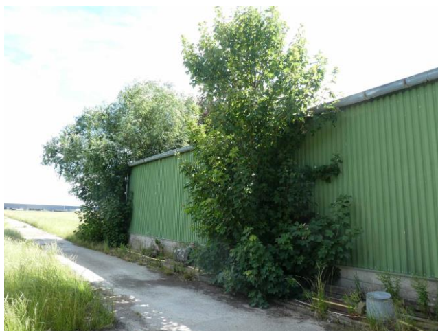
Figuur 14 Buitenzijde schuur 2
