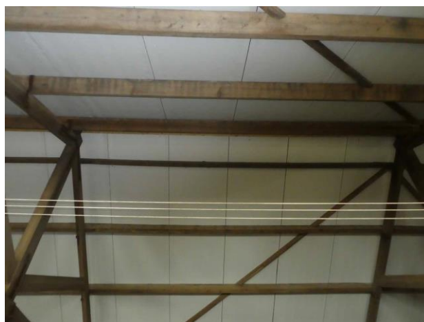
Figuur 21 Binnenzijde dakconstructie schuur 4
