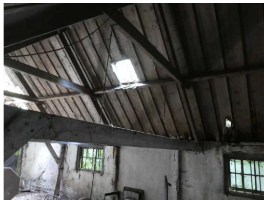
Figuur 23 Dak schuur 5
