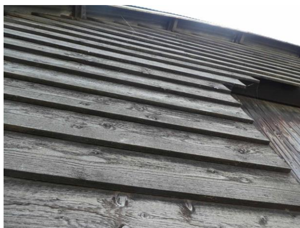
Figuur 15 Planken gepotdekseld aangebracht
