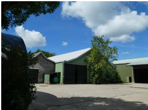
Figuur 20 Buitenzijde schuur 4
