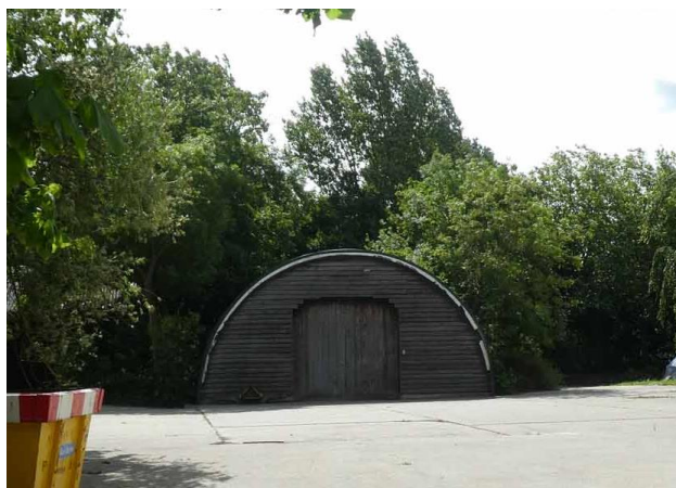
Figuur 16 Romney loods
