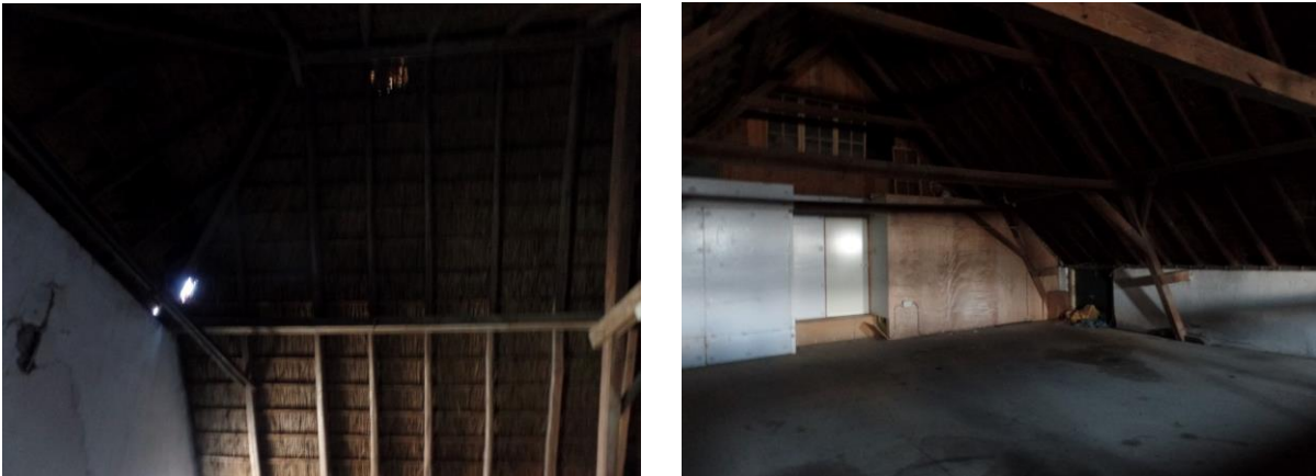
Figuur 9: Opening in de rieten dakbedekking van het woonhuis en interieur van de zolderverdieping.
